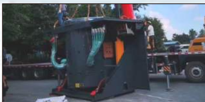
Монтаж и ввод в эксплуатацию
